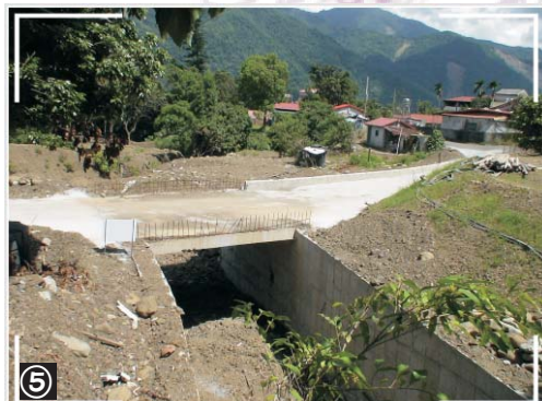
①、②、③已幾近完工的蓮生一號橋。④尚在施工中的蓮生二號橋。⑤尚在施工中的蓮生三號橋。
